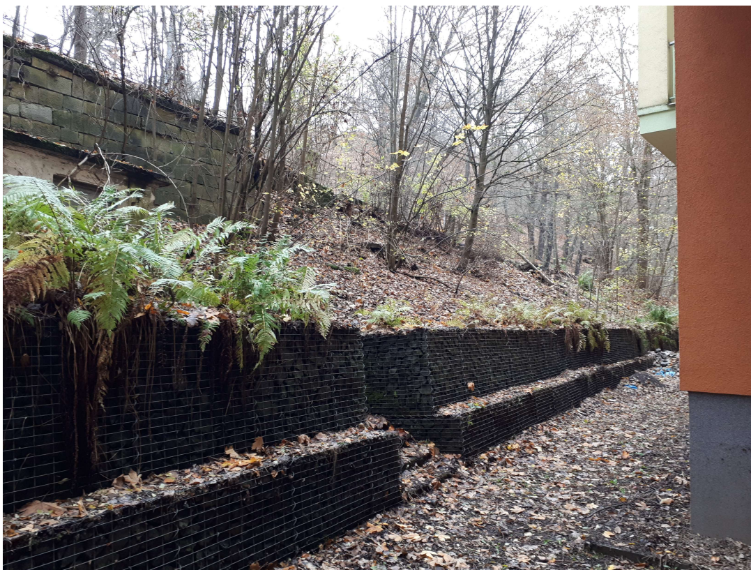
Obrázek č.6 - foto detail střední části svahu s chodníkem a zbytky opěrné zdi
