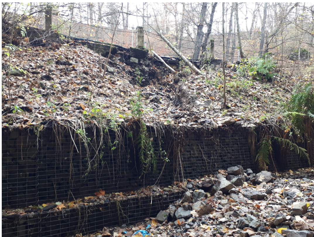
Obrázek č.7 - foto detail střední nižší části svahu s erozí vyvolanou povrchovou vodou
